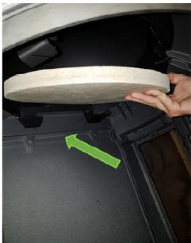
Setzen Sie den Deflektor schräg in die Haube ein
